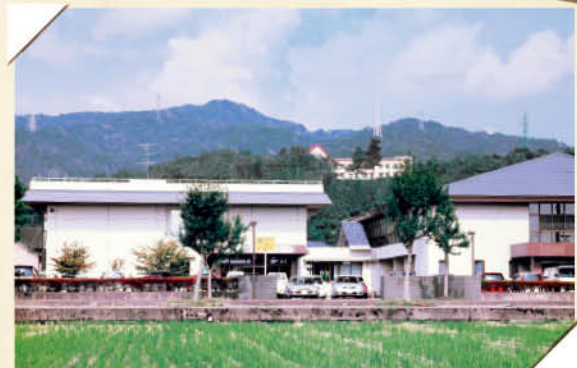
竣工当初の建物
